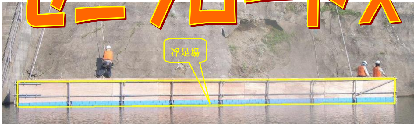
法面工事作業中
